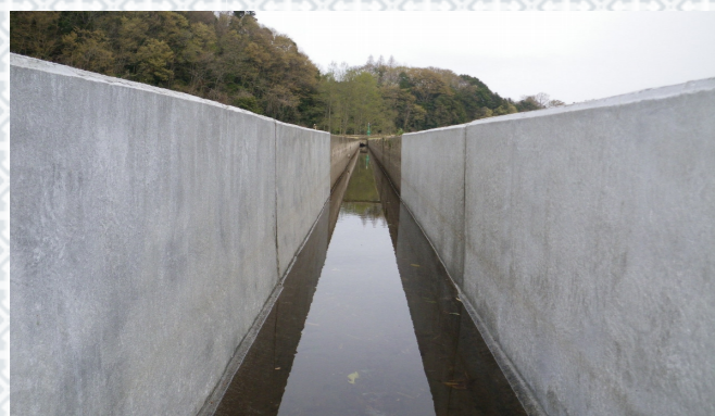
Kỹ thuật sửa chữa đường dẫn nước
