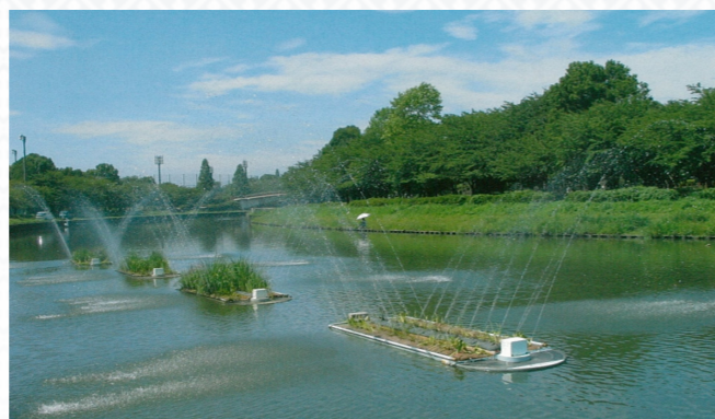
Hệ thống lọc nước ở đảo nổi Đảo Amenbo
