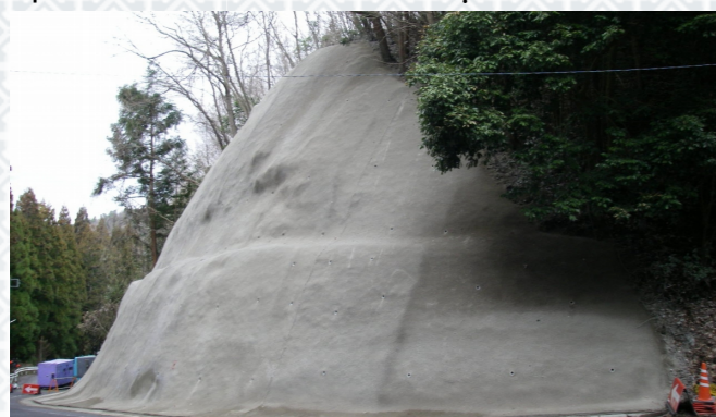
Đặt bu lông mặt cắt + Máy phun vữa gia cố bằng sợi Polypropylen
