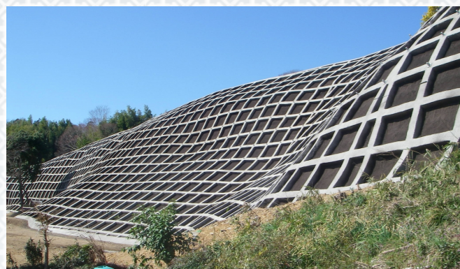
Công việc phun keo khung + công việc chèn cốt thép (đặt bu lông khoá)
